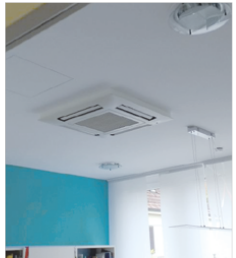
VRF-Kassettengeräte mit Abstandsrahmen
