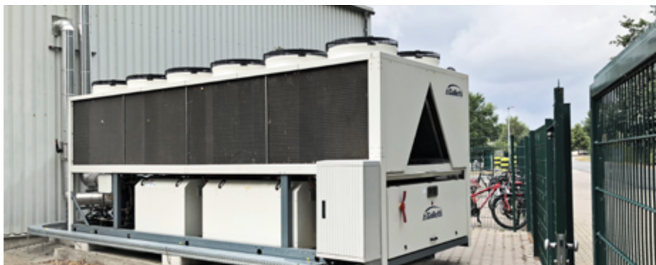
LSE800CL 564,3 kW Kälteleistung bei -2 °C Vorlauftemperatur
