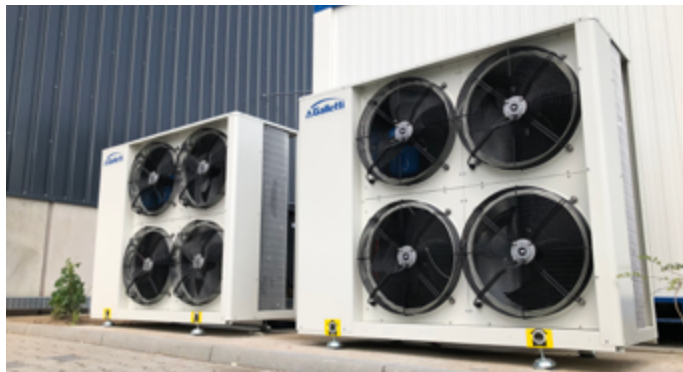
MPE027C Zwei Geräte mit je 30 kW Kälteleistung
