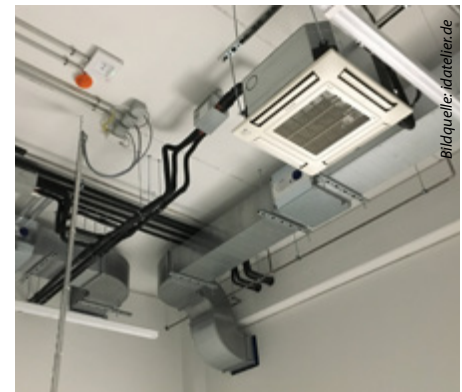
Offene Montage der Kassettengeräte
